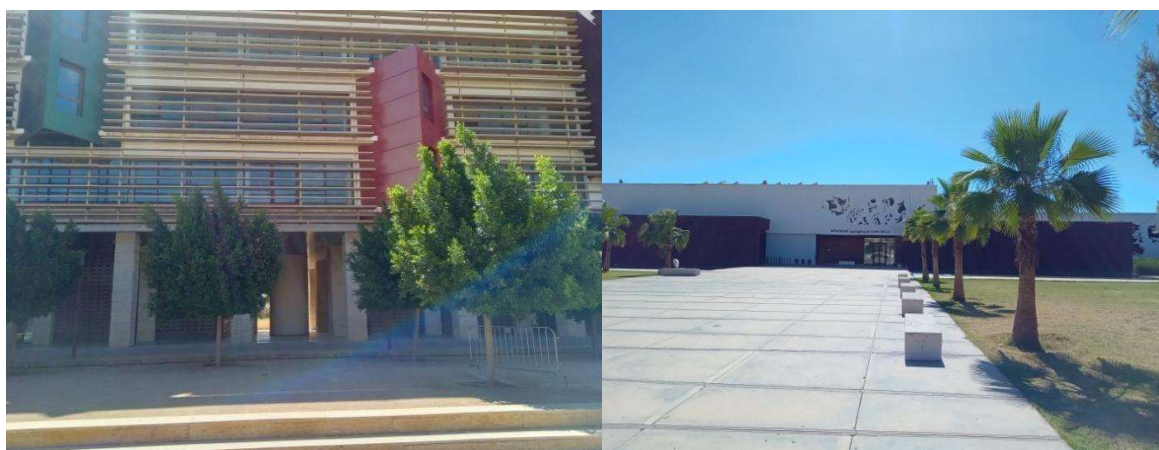
FIG 15. À gauche. Photo d'un détail du lycée 1337 de Khouribga où on peut reconnaître une des ouvertures aménagées dans le bâtiment pour assurer une aération naturelle.
