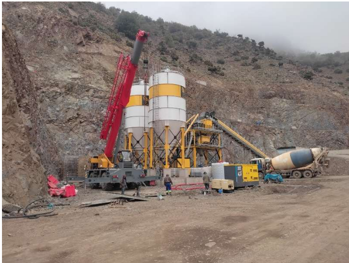
Figure 2: le nouveau barrage de Tassa Ouirgane
